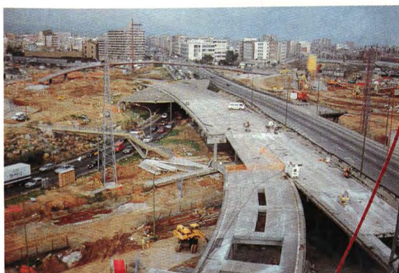
Plaza de las Glorias (Barcelona). Técnica: Disco de diamante, gatos hidráulicos y pinza demolidora.
