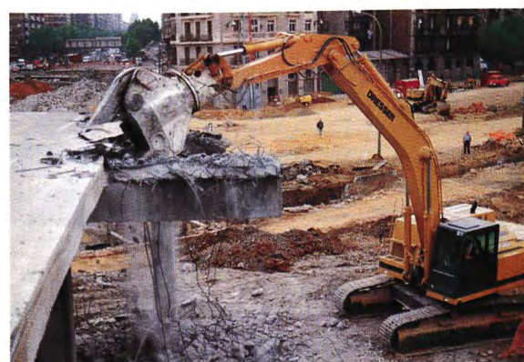
Demolición de hormigón. Técnica: Pinza demolidora.
