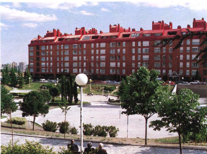
Arganzuela. Nueva construcción antigua fábrica de gas.
